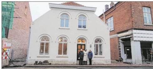
Günter und Lore Prahm und ihre Mitarbeiterin Petra Köster freuen sich über die gelungene Sanierung des Gebäudes.
