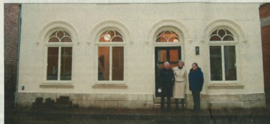
Günter Prahm, seine Ehefrau Lore und seine Mitarbeiterin Petra Köster vor der Fassade des sanierten Hauses Norderstraße 51. Hier sind acht Einraum-Wohnungen entstanden.
