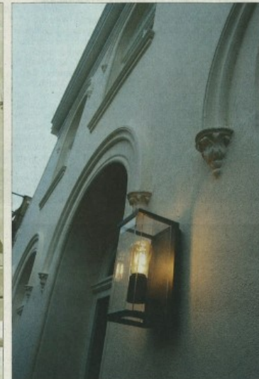
Die Gestaltung der vorderen Fassade des sanierten Hauses Norderstraße 51 lehnt sich an das historische Vorbild an. Moderne Lampen setzen dabei Akzente.
