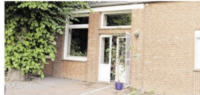
Das Wohnheim ist vorerst gesperrt.
