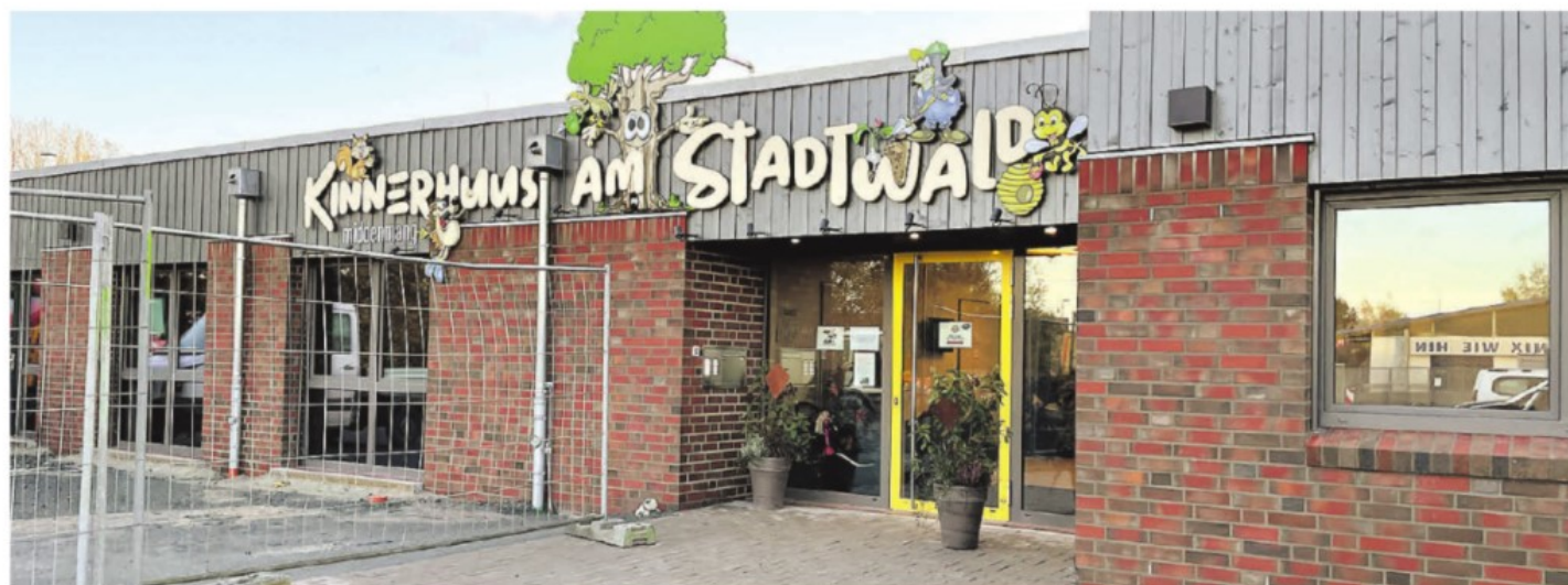
Draußen wird noch gepflastert, drinnen längst gespielt: Die neue obw-Kita in Harsweg.
